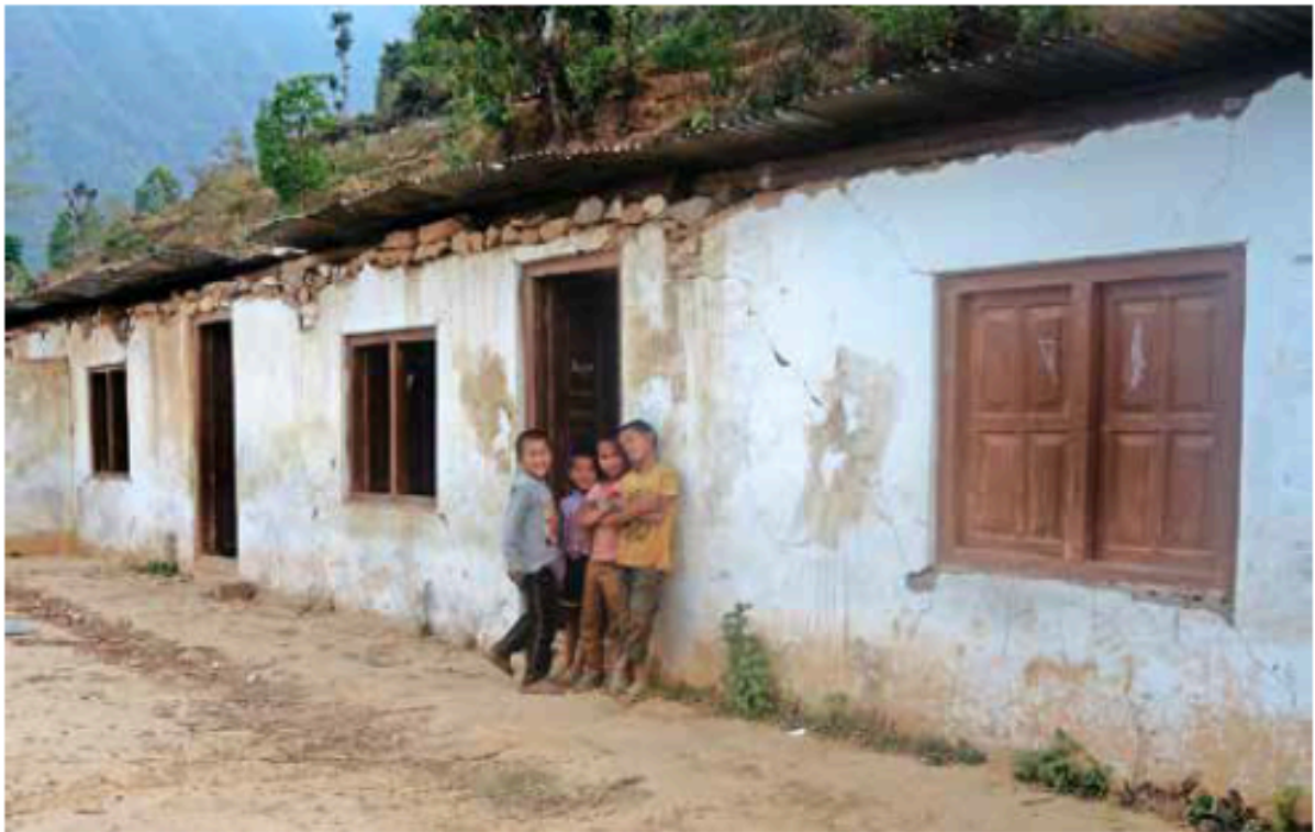
Wiederaufbau der durch das Erdbeben von April/Mai 2015 zerstörten Schule in Kaule, Nepal.
